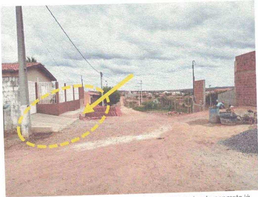
**Figura 5** - Locais do Trecho a ser pavimentado com passeios de concreto já existentes, fora do padrão de acessibilidade a serem demolidos
