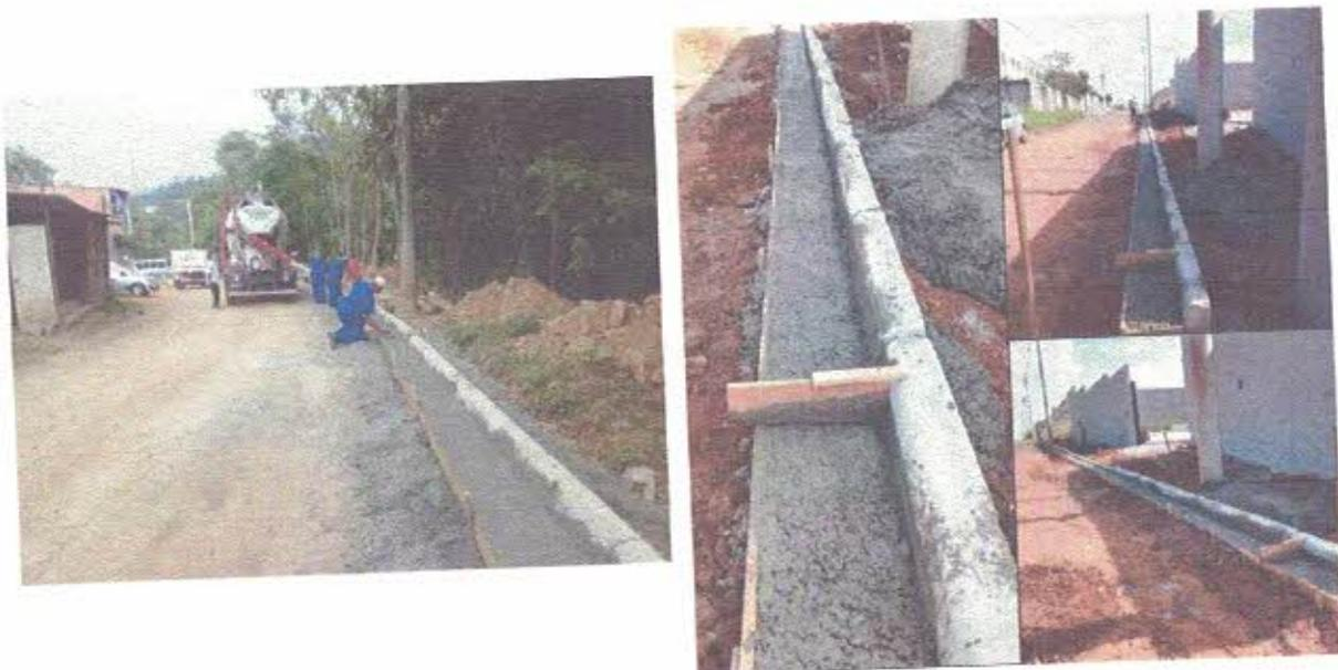
Figura 10 – Execução de Meio-fio e sarjeta pré-moldado
